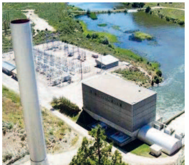
Vue aérienne du barrage hydroélectrique d'Inga
