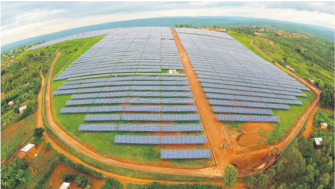
La première centrale solaire de grande taille de l'Afrique orientale a commencé à fournir de l'énergie en février 2015. (Gigawatt Global)
