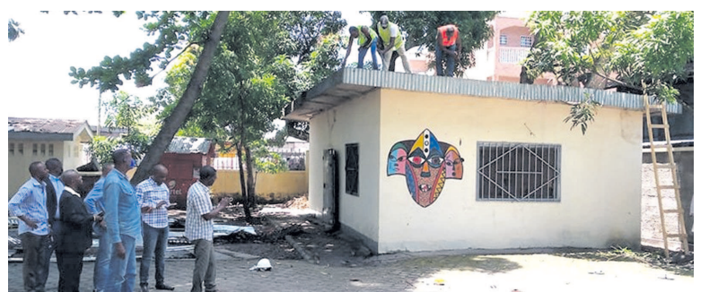
Le bâtiment en réhabilitation abritera la galerie virtuelle de l'école (crédit photo/Adiac)
