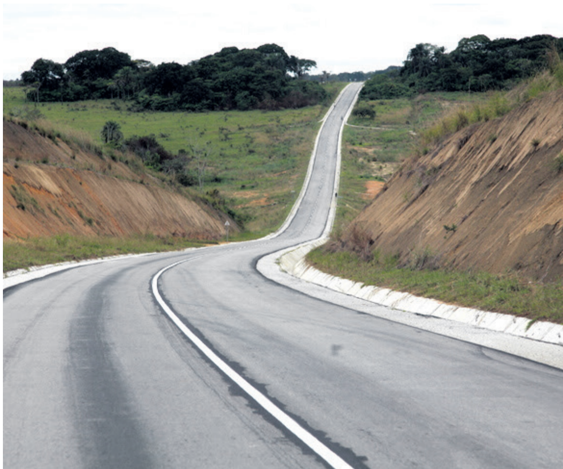
Un tronçon de la route bitumée Obouya-Boundji-Lékéty
