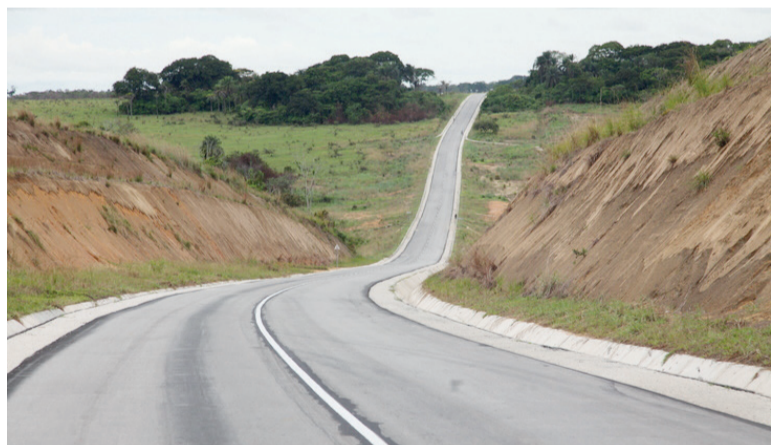
Un tronçon de la route bitumée Obouya-Boundji-Lékéty
