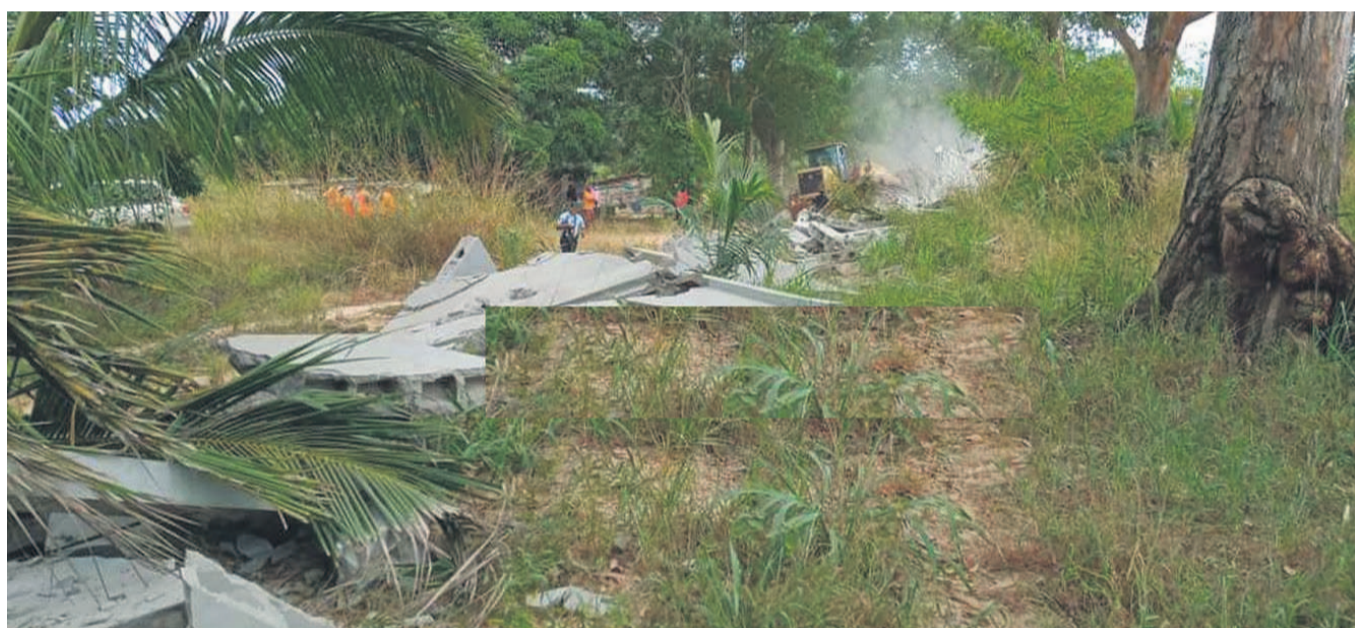
L'opération de démolition DR
