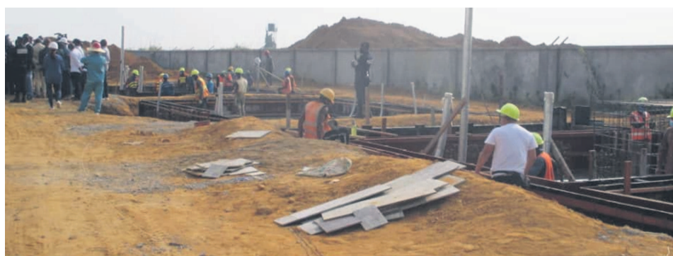
Travaux de construction des plateformes servant à la pose des transformateurs
