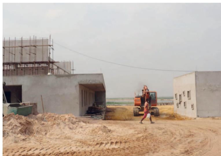
L'état d'avancement des travaux du port de Yoro/Adiac
