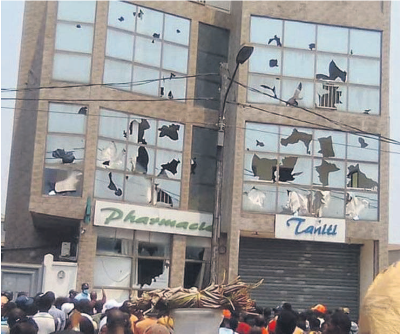
La pharmacie vandalisée à Total
