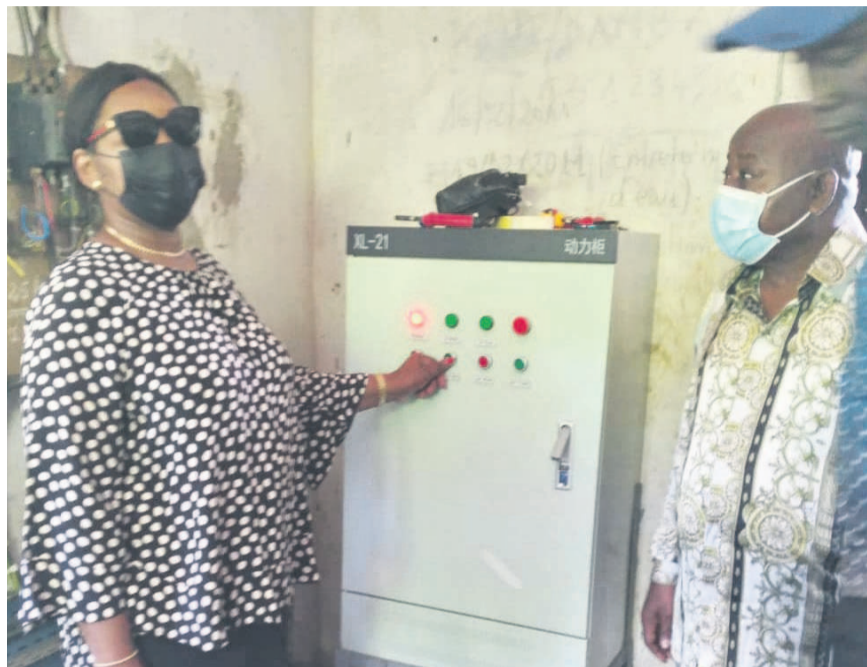
La ministre constatant la réhabilitation des équipements
