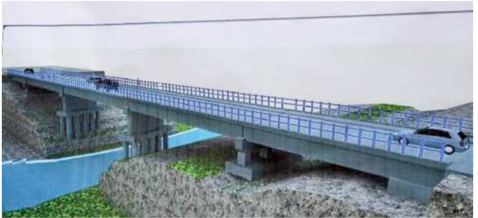
La maquette du pont en passe d'être érigé au Camp Luka
