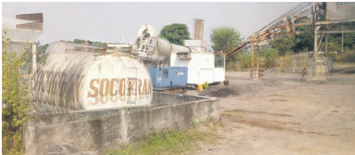
Un entrepôt d'essence à deux ou trois mètres de l'usine DR
