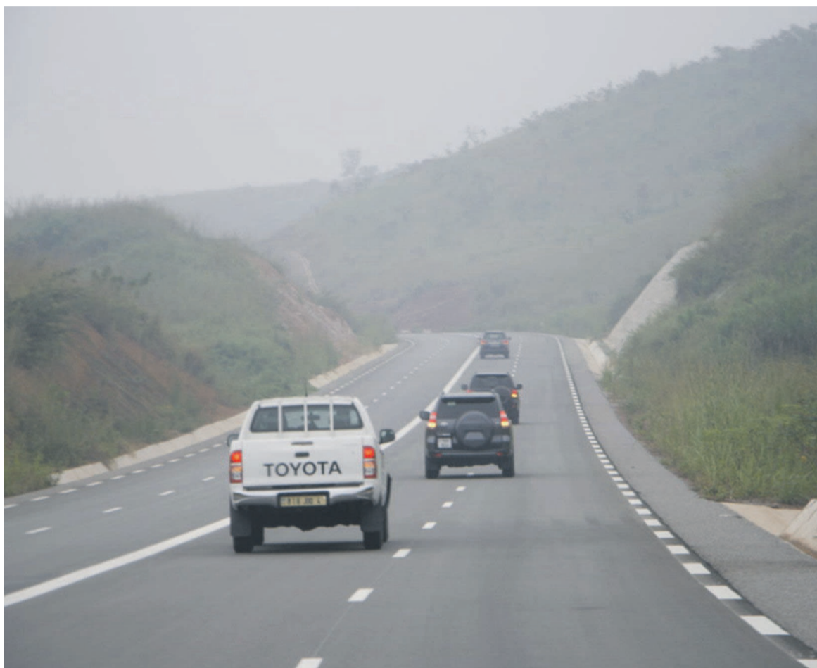
Une route bitumée Photo Adiac
