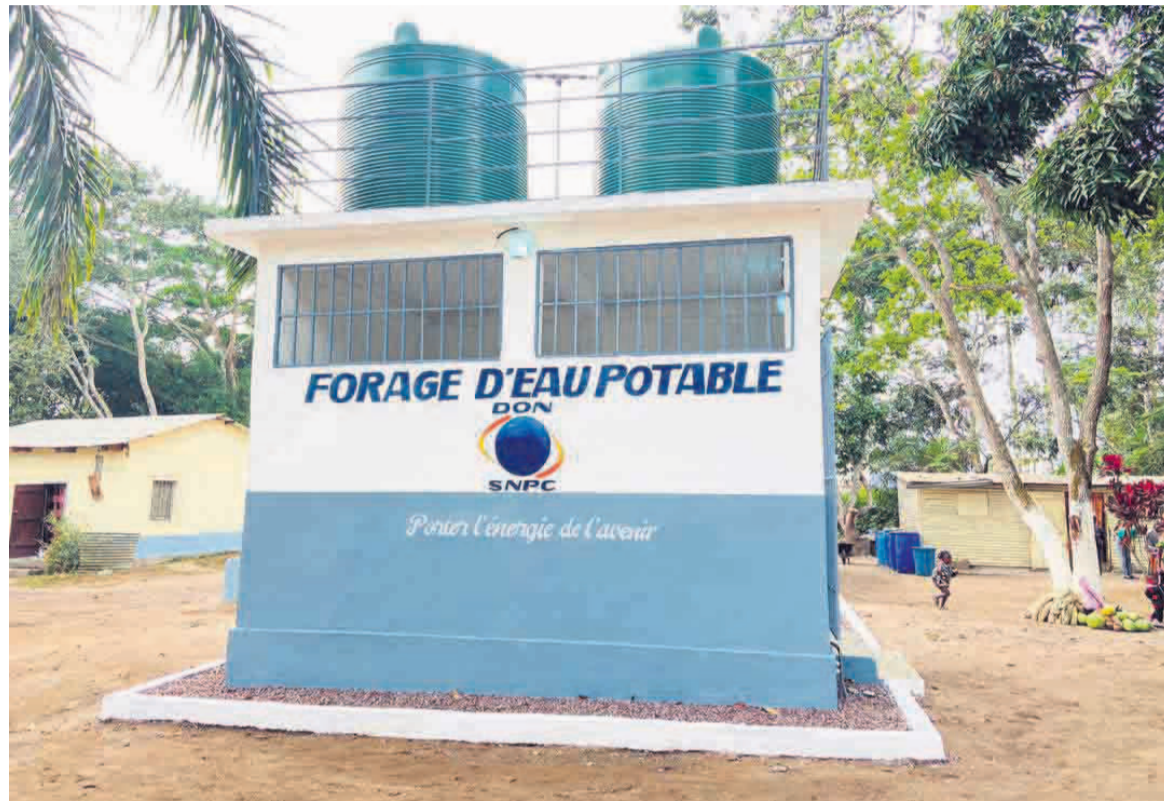
La première phase du projet de construction des forages qui va s'étendre jusqu'à Inoni-Plateaux avec un total de 21 forages/Adiac
