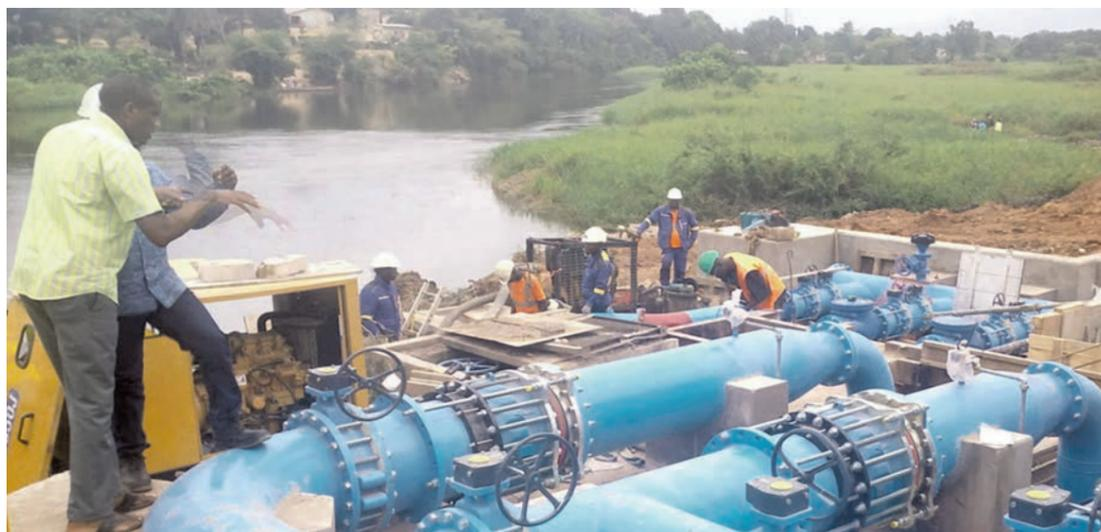
Une vue des électropompes au niveau du captage d'eau de l'usine du Djoué/Adiac
