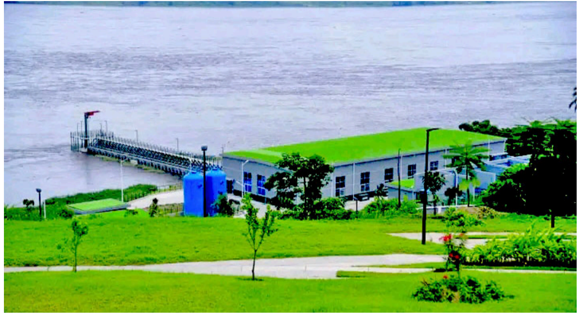
L'usine de captage et de traitement d'eau de Binza Ozone
