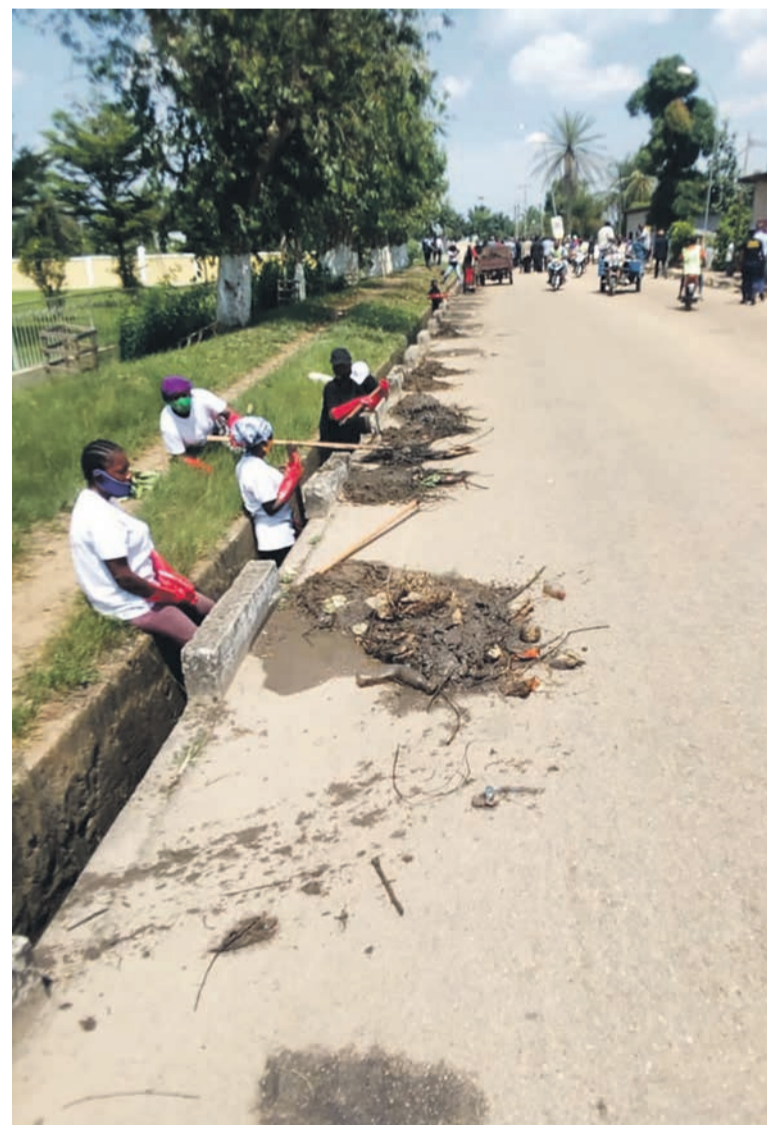
Les travaux d'assainissement à Owando/Adiac
