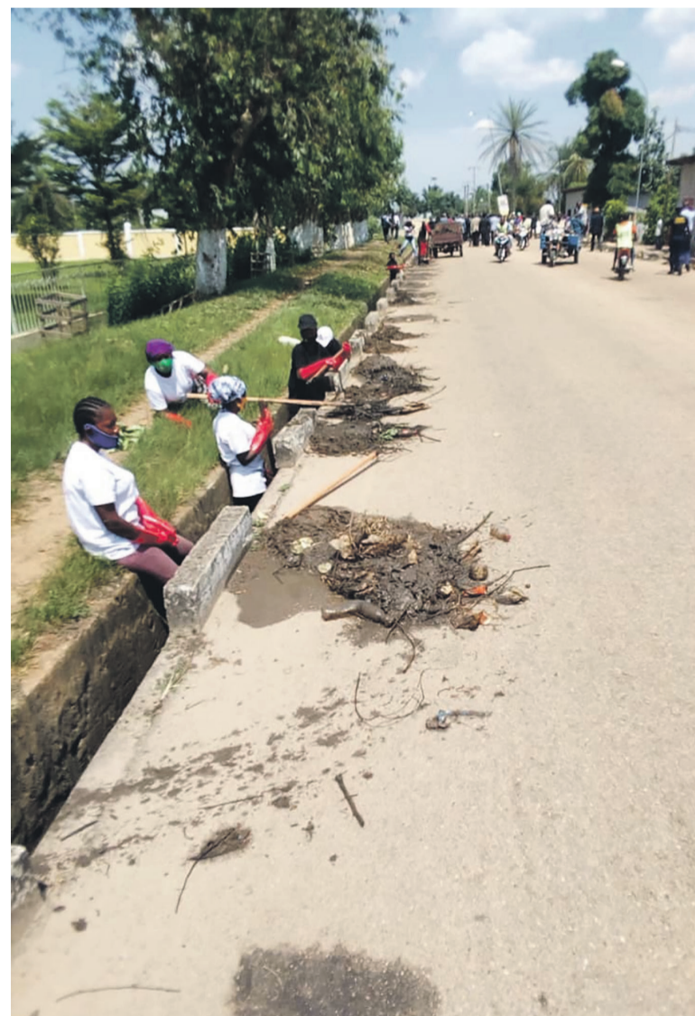
Les travaux d'assainissement à Owando/Adiac
