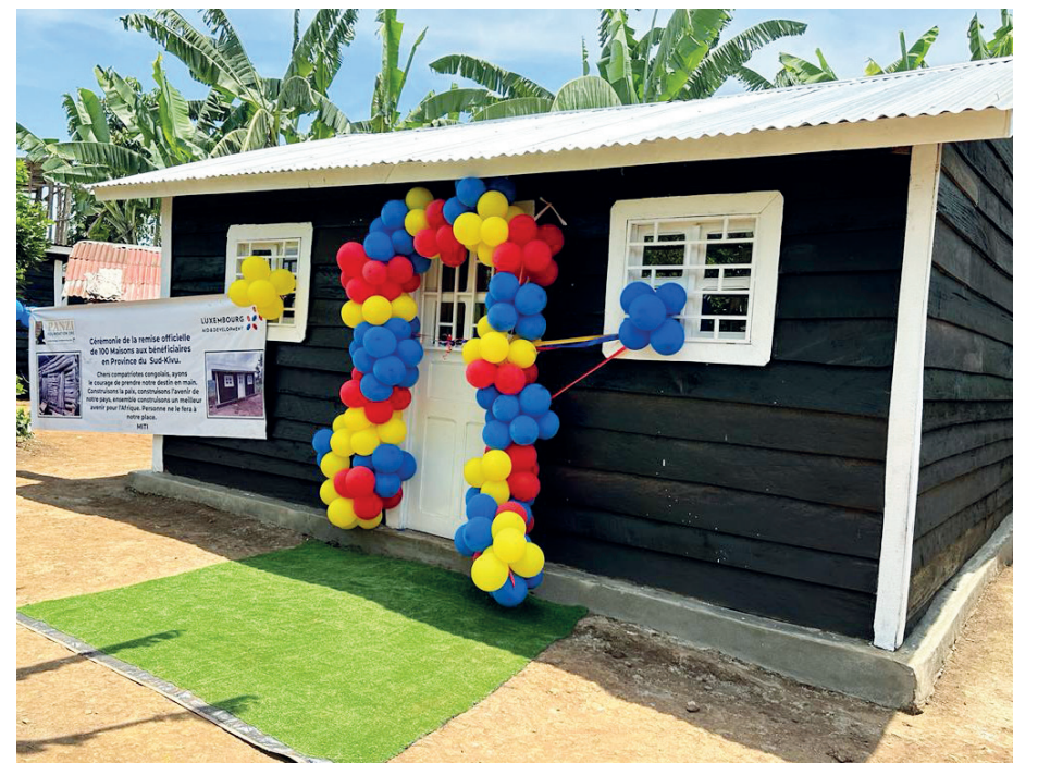
Une des maisons construites par la Fondation Panzi pour les survivantes des violences sexuelles
