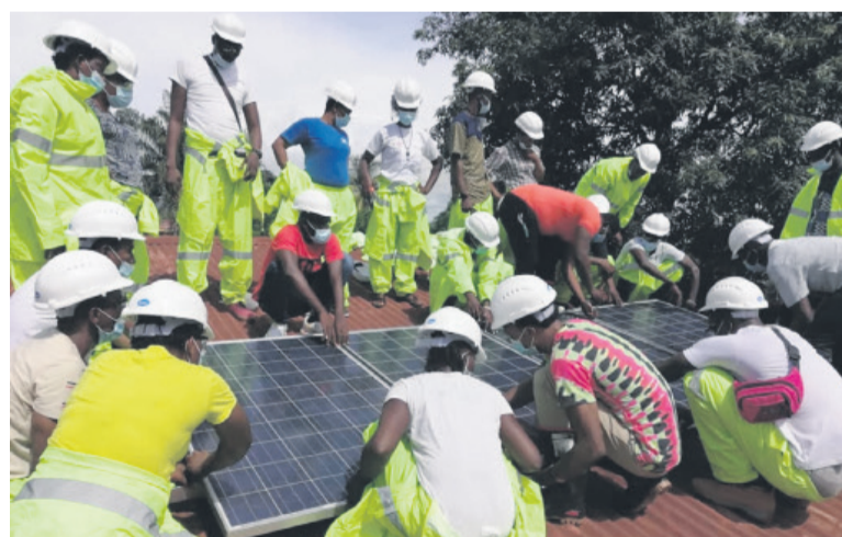
Des étudiants de l'Agro-solar Academy en Sierra Leone installent une pompe à eau solaire et apprennent à utiliser des instruments de mesure. © Projet de développement des compétences au Sierra Leone, 2021
