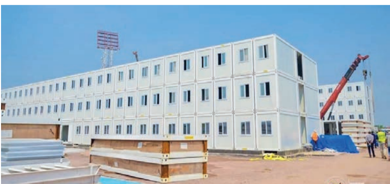
Un site des Jeux de la Francophonie en construction
