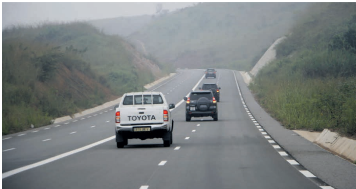
La route nationale 1, tronçon Yié-Mindouli/Adiacion, la piraterie et la criminalité en mer ; la construction des ports et autres plateformes de transport maritime pour faciliter les échanges commerciaux ainsi que l'utilisation rationnelle des cadres», a précisé Honoré Sayi.
