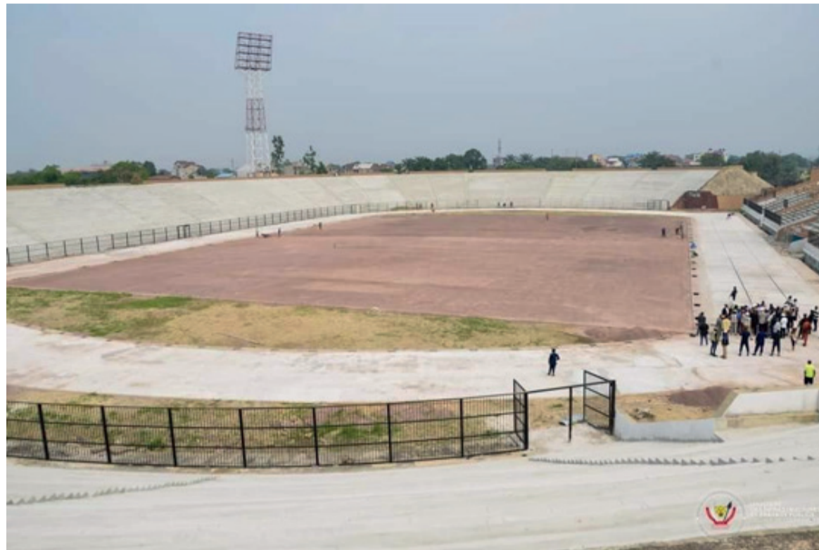
Le stade Tata Raphaël en réhabilitation
