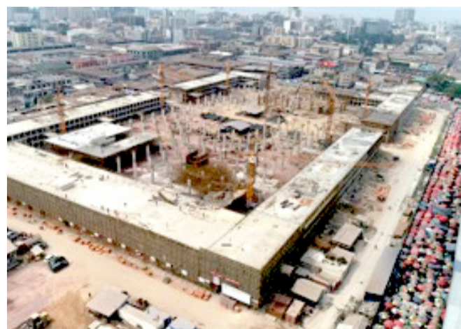
Vue aérienne du chantier du nouveau marché de Kinshasa
