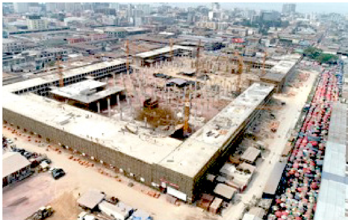
Vue aérienne du chantier du nouveau marché de Kinshasa
