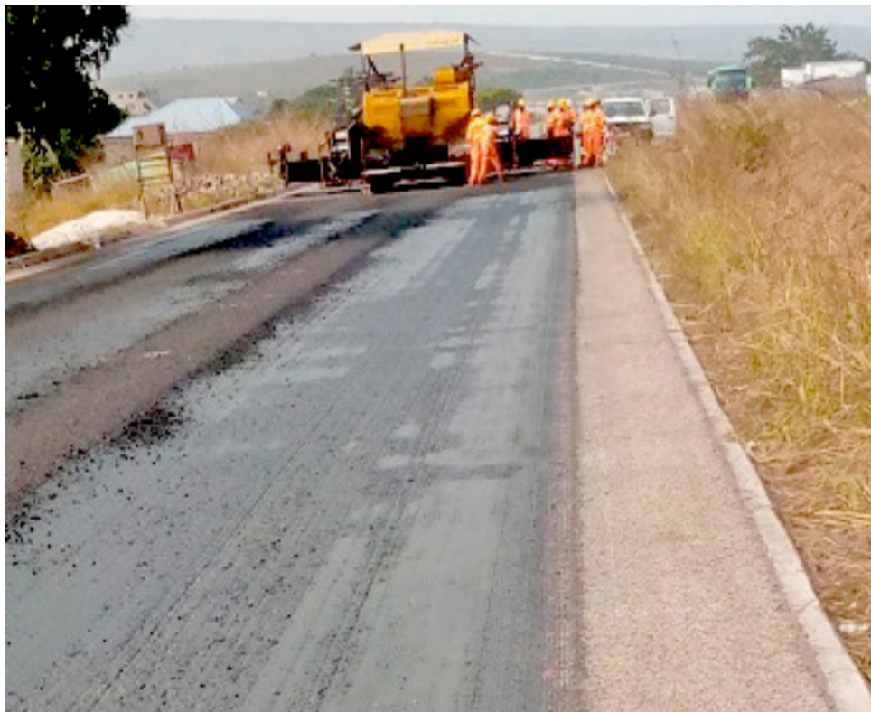
La surface de la chaussée renouvelée/Adiac
