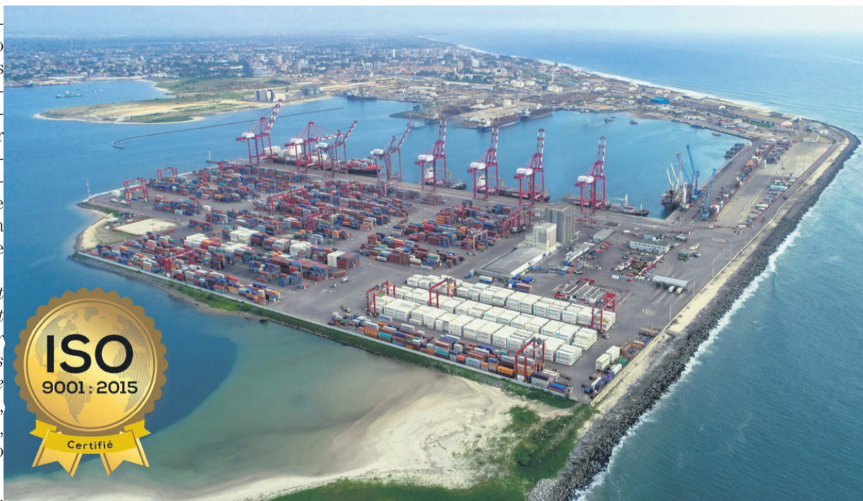
Vue aérienne des installations de Congo Terminal au port de Pointe-Noire/DR
