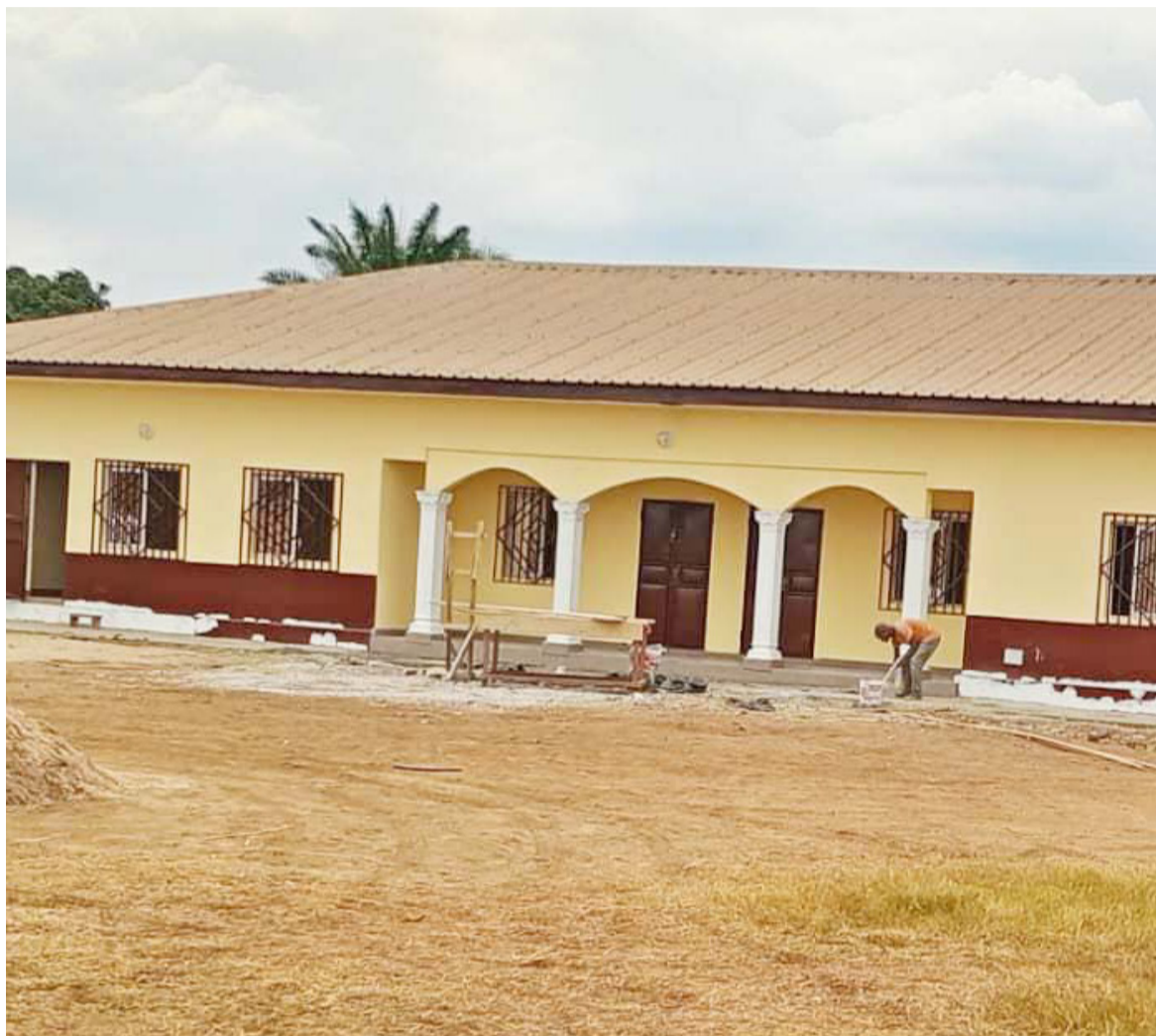
Un des bâtiments du lycée de Nkayi 2
