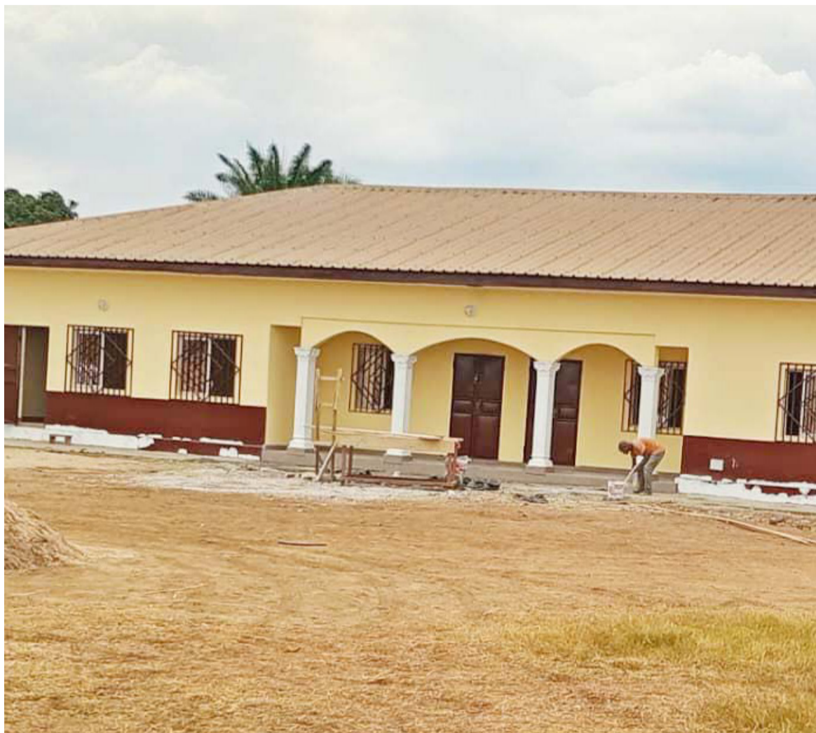
Un des bâtiments du lycée de Nkayi 2
