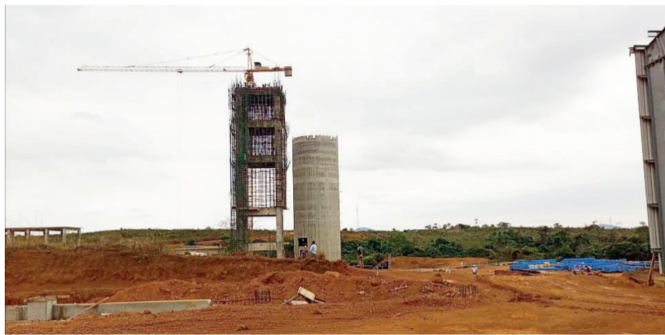
Une vue des travaux déjà réalisés/DR
