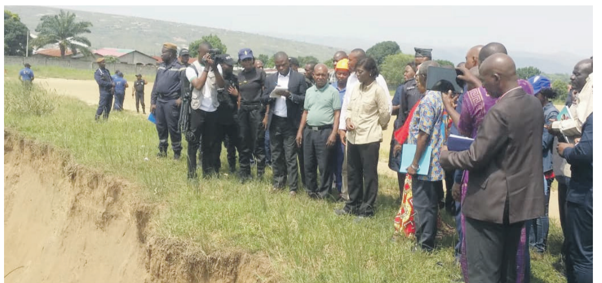
La ministre constatant la gravité d'une érosion/Adiac
