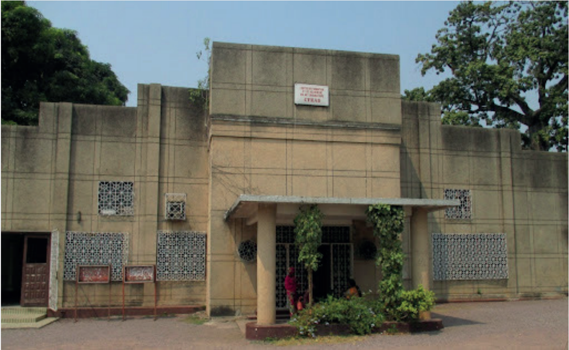
Une vue du bâtiment du Cfrad/DR
