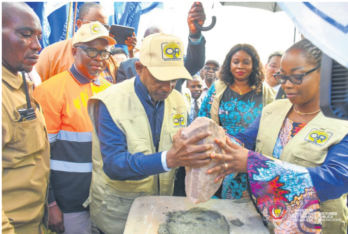
Alexis Gisaro lançant les travaux de réhabilitation de la RN 4/DR
