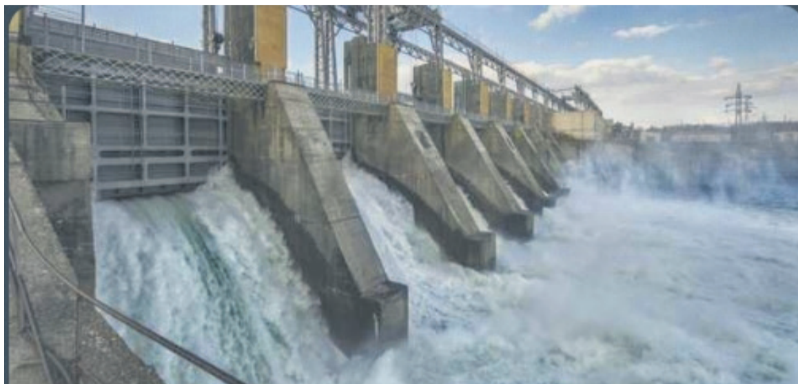
La Centrale hydroélectrique d'Inga 2/DR
