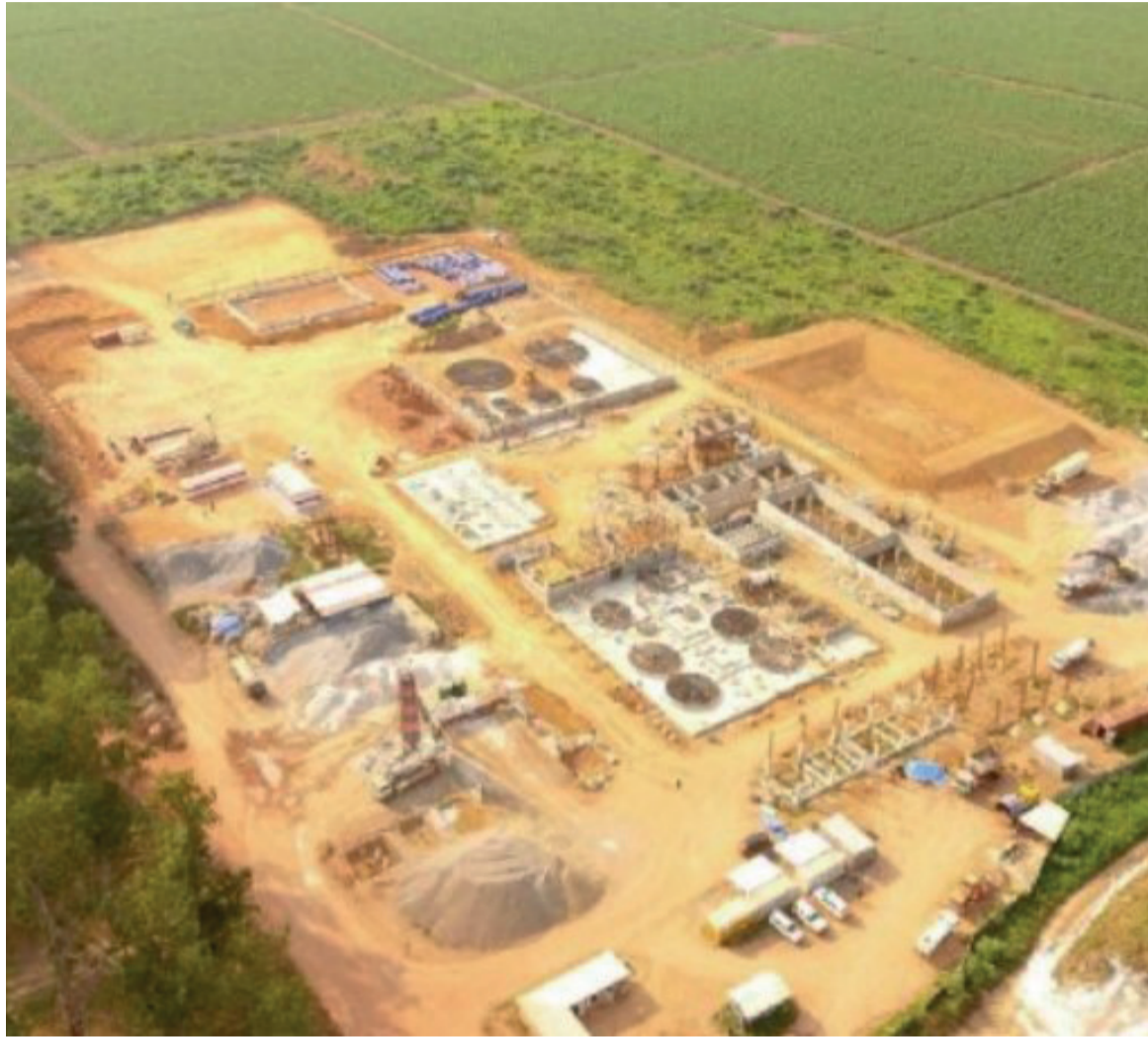
Le chantier de la distillerie à Nkayi-Moutela/DR
