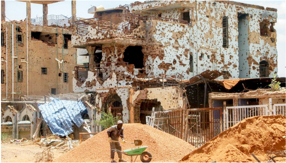
Dans la banlieue de Lamab, au sud-ouest de Khartoum, les ouvriers déblayent les décombres des maisons criblées de balles, ramassent les arbres tombés et réparent les lignes électriques endommagées. © Crédit photo : Ebrahim Hamid/AFP
