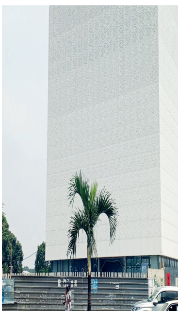
L'immeuble du Datacenter en construction
