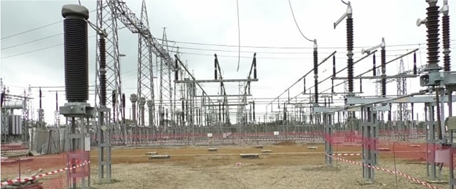
Le niveau d’exécution des travaux du Poste de Dolisie/DR
