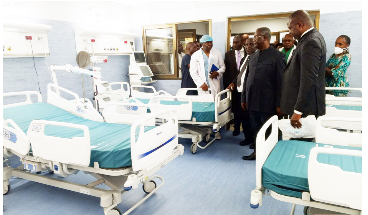
Le Pr Jean Rosaire Ibara visitant les travaux de rénovation du service de réanimation/DR
