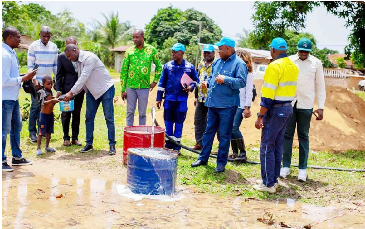
Maixent Raoul Ominga (au milieu en bleu ) inspectant les travaux/DR
