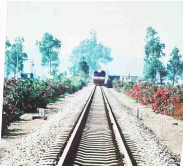
Une vue de la voie ferrée à rénover / Adiac-tures de voyageurs.
