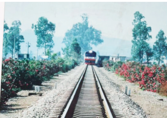
Une vue de la voie ferrée à rénover
