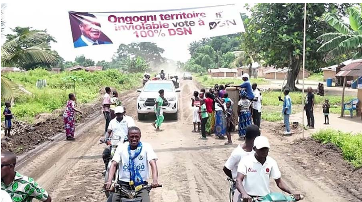
Les habitants de l'axe Ongogni-Lessanga satisfaits de l'aménagement de leur tronçon routier/DR
