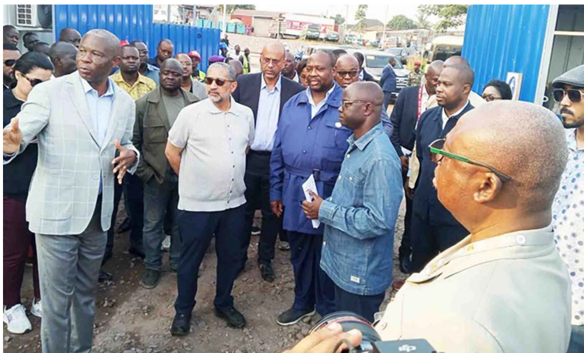
Jean Jacques Bouya et Abdullah KH Almusaibeh visitant le chantier/Adiac
