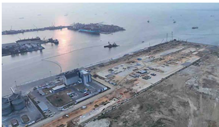
Une vue aérienne du dragage au Môle Est/Photo Congo Terminal
