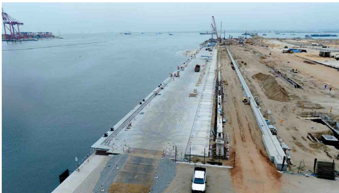
Une vue du quai en construction au Môle Est, au port de Pointe-Noire/DR
