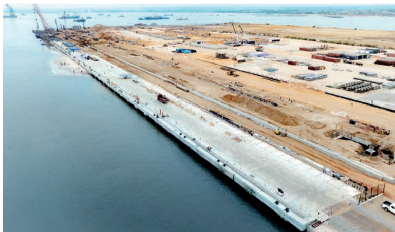
Une vue du quai en construction au Môle Est, au port de Pointe-Noire
