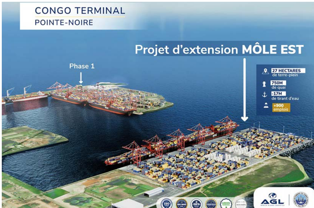
Maquette du Môle Est en construction au Port autonome de Pointe-Noire/DR
