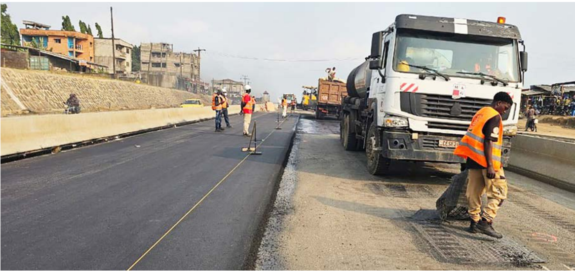
Un axe routier en cours de réhabilitation au Cameroun/DR
