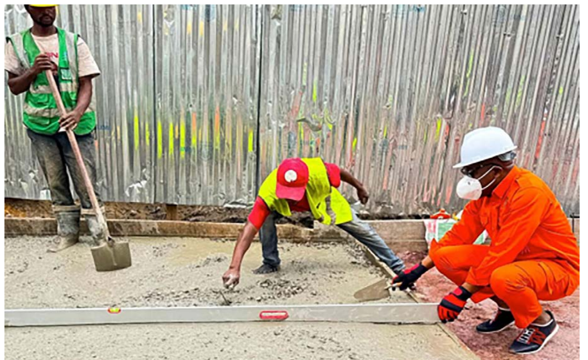
Le ministre Juste Désiré Mondélé sur le chantier de l'Avenue des blindés/Adiacières
